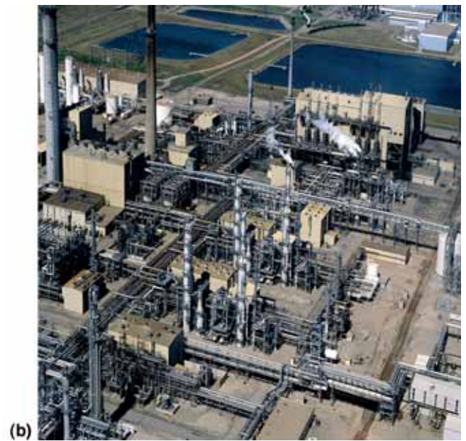
Gráfico RT-4. a) Captación de CO 2 posterior a la combustión en una planta de Malasia. Esta planta utiliza un proceso de absorción química para separar 0,2 Mt de CO 2 al año del flujo de gas de combustión de una central eléctrica alimentada por gas para la producción de urea. (Por gentileza de Mitsubishi Heavy Industries). b) Captación de CO 2 previa a la combustión en una planta de gasificación de carbón en Dakota del Norte, Estados Unidos. Esta planta utiliza un proceso de solvente físico para separar 3,3 Mt de CO 2 al año de un flujo de gas para producir gas natural sintético. Parte del CO 2 capturado se utiliza para un proyecto de recuperación mejorada de petróleo en Canadá.
