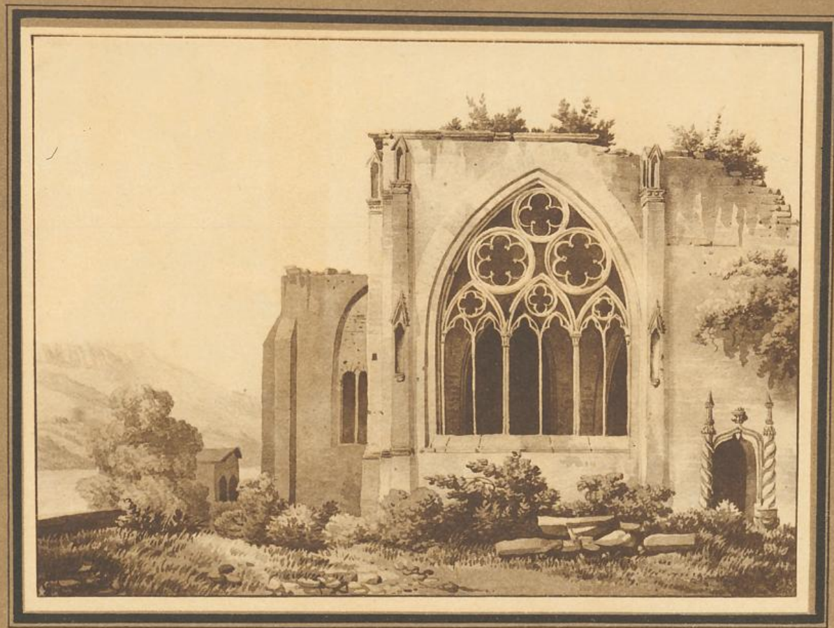
Exterieur de la Chapelle des Ducs de Savoie.
