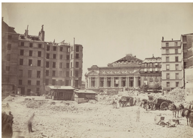
Louis-Émile Durandelle, Chantier de construction de l'Opéra Garnier. Vue des abords de la place de l'Opéra avec amas de gravats Photographie BnF, Bibliothèque-musée de l'Opéra
